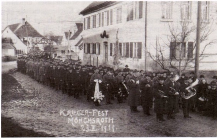
Das „Neue Schulhaus“ 1919
