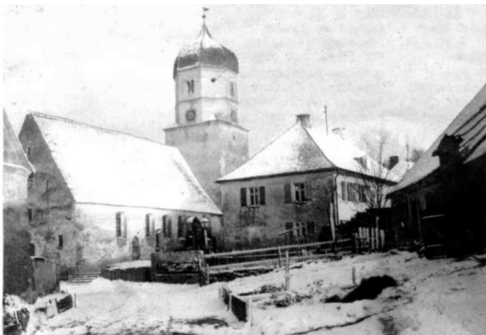
Das alte Schulhaus neben der Kirche um 1920
